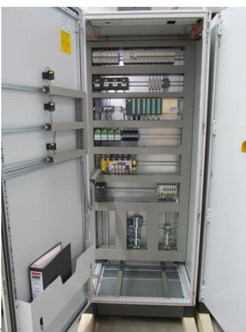
**2St. Steuerschränke:** Mit Speicherprogrammierbarer Steuerung für die Regelung und Bedienung der Anlage
