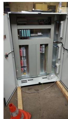
**2St. RIO:** Remote-I/O Verteiler für die Signalübertragung in der Anlage
